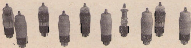
La serie a 6,3 v. - 150 mA - nelle due presentazioni: in primo piano le metallizzate, dietro le non metallizzate
